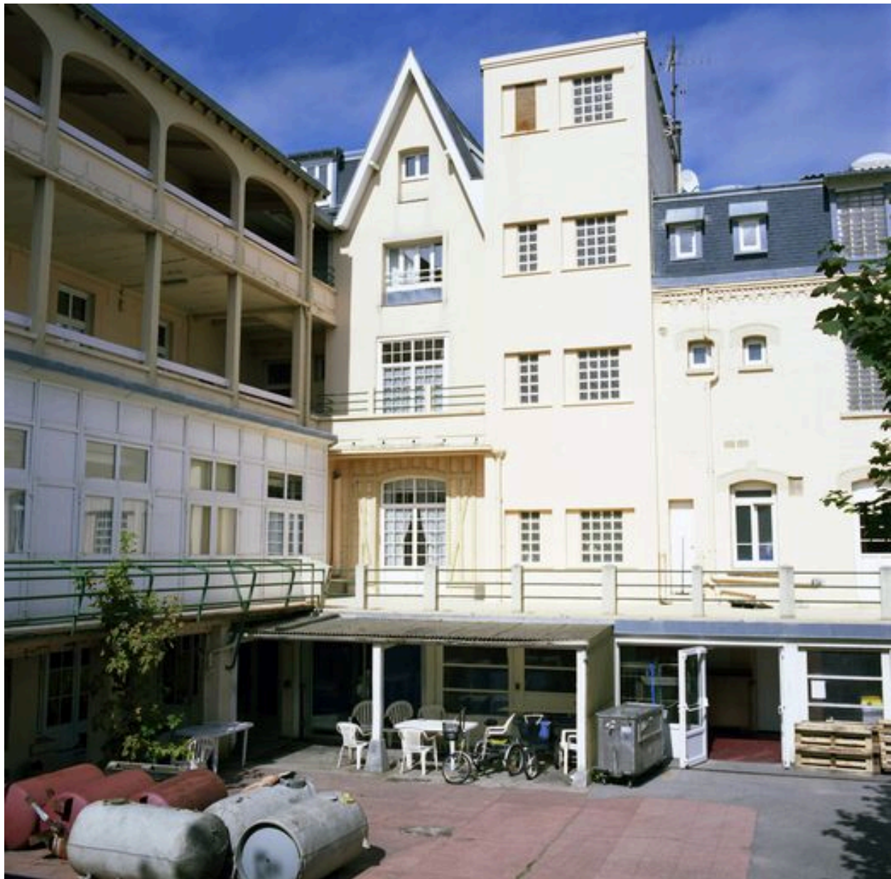
Angle des corps de logis donnant sur les rues de Lhomel et Eugène-Trigoulet, élévation postérieure.
