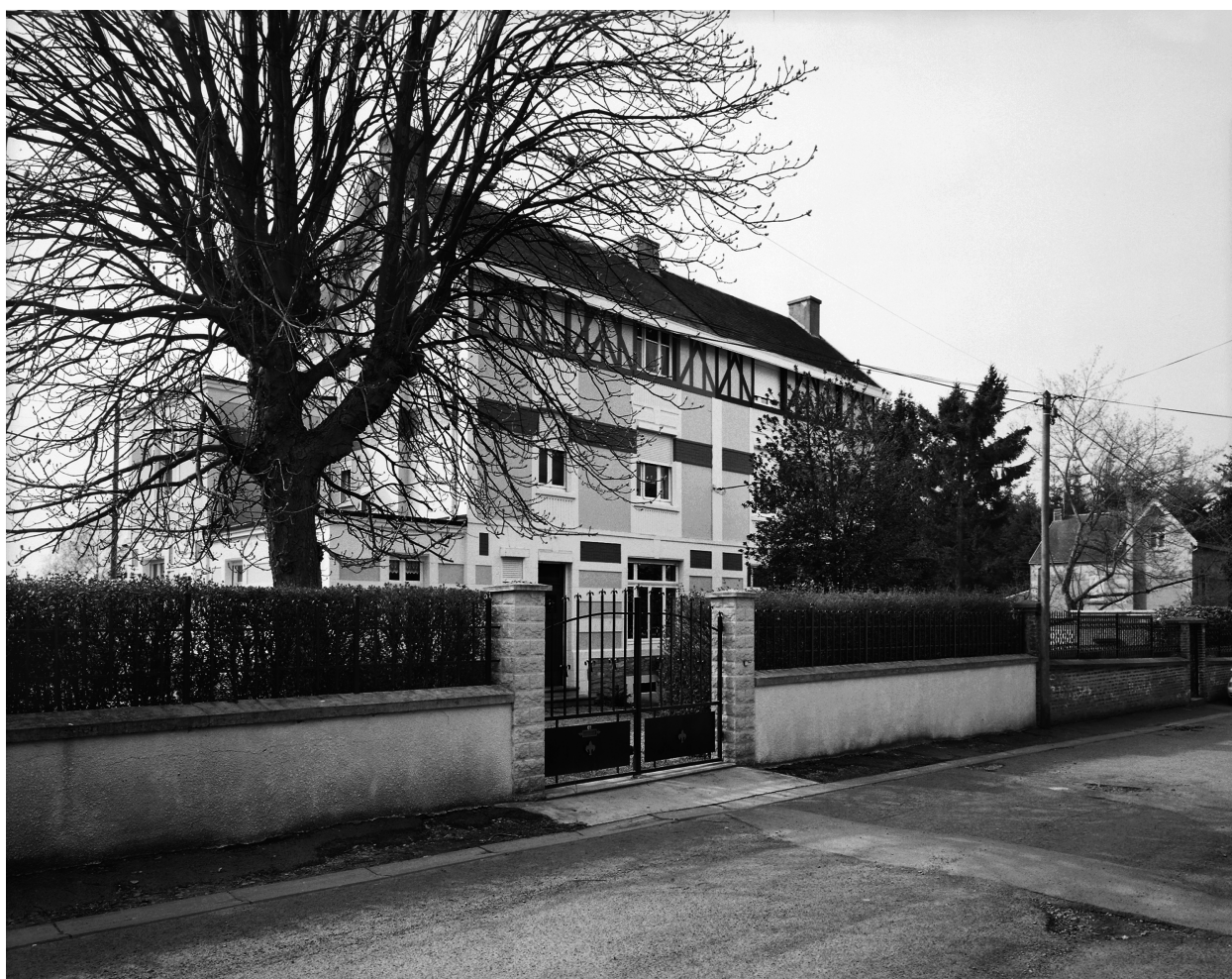
Vue générale d'un module.
