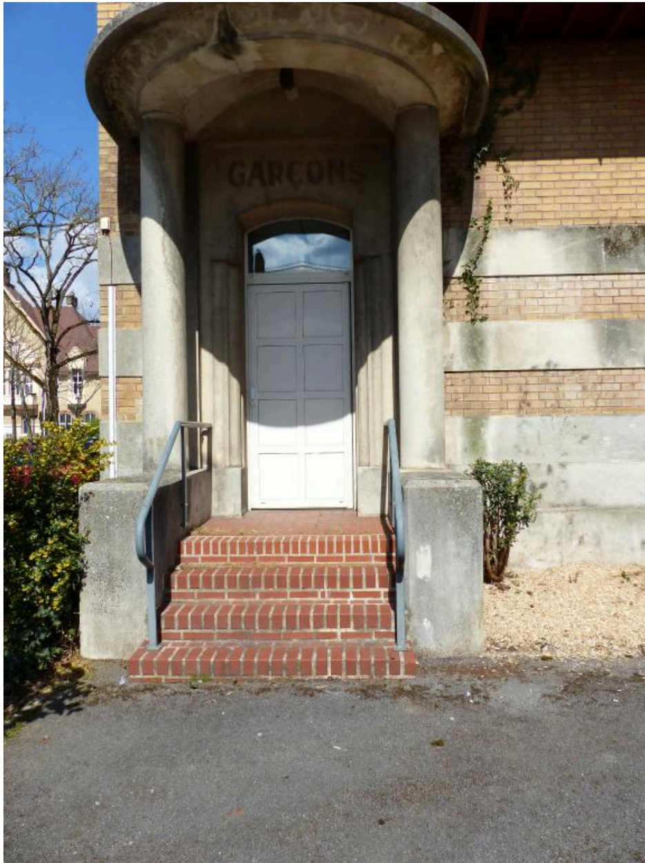
Porte de l'école de garçons (pignon sud).
