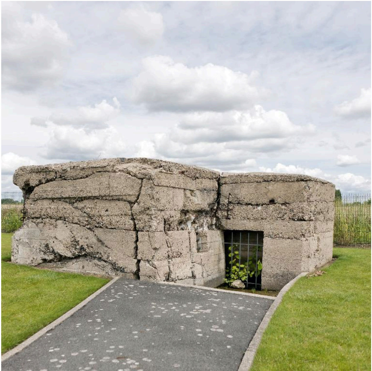
Casemate (f), vers le nord-est
