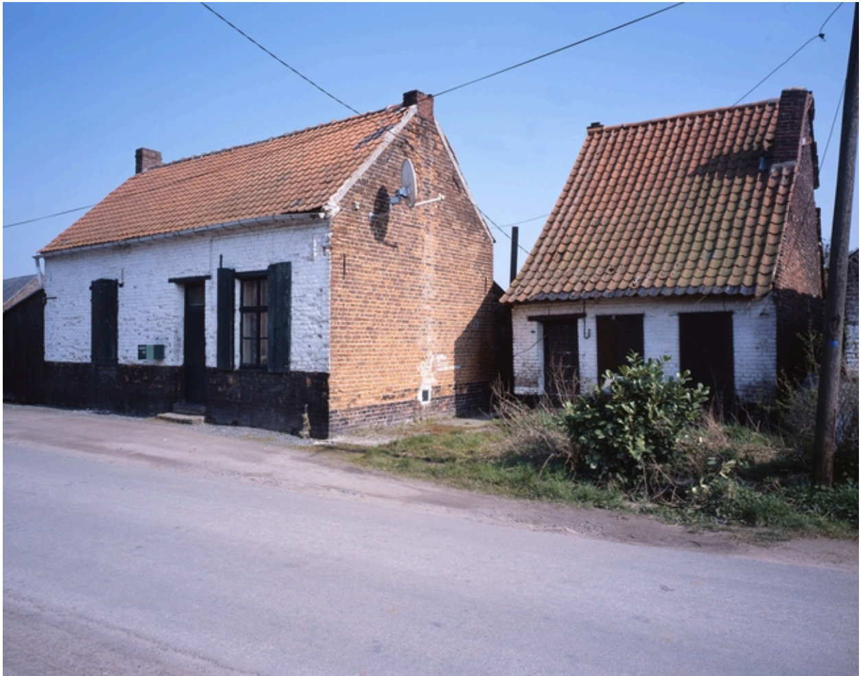
Ensemble de maisons d'ouvriers agricoles, rue de la Lombarderie.
