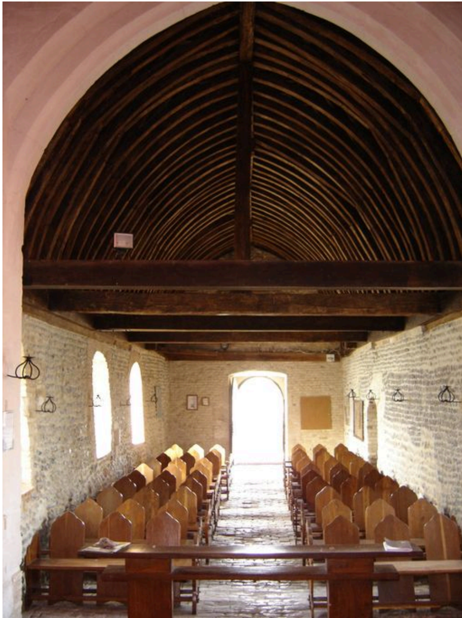
Vue intérieure de la nef depuis l'est.
