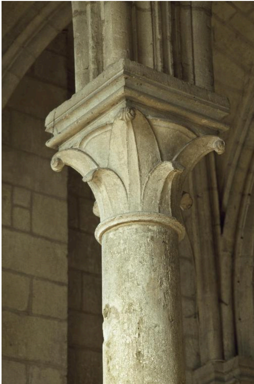
Bras sud du transept : chapiteau d'une des colonnes de l'entrée de la chapelle basse.
