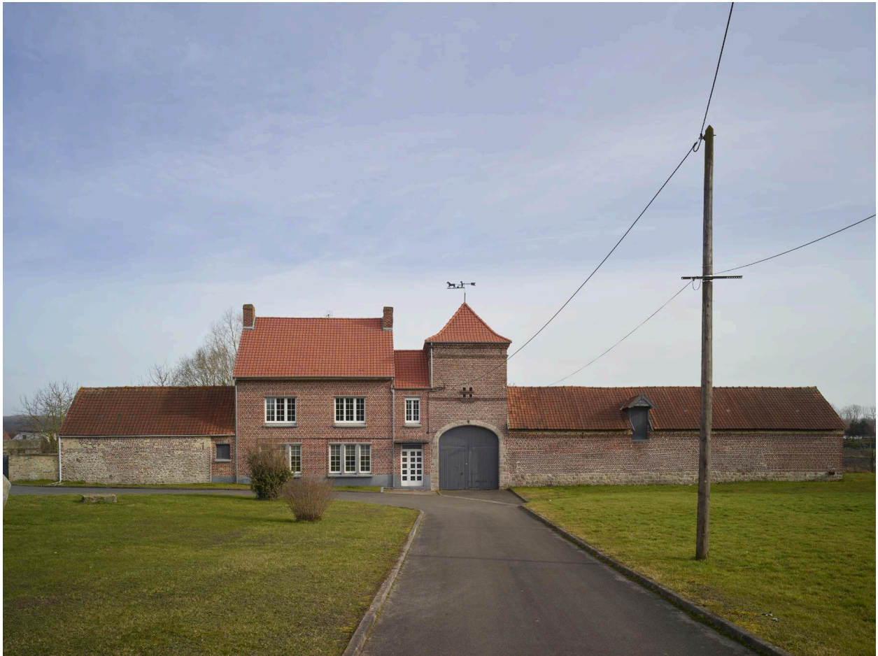
Façade sur rue. Tour porche et logis à gauche.
