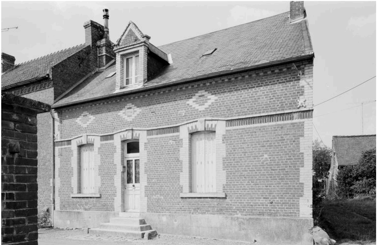
Maison repérée datée 1924. Élévation antérieure.
