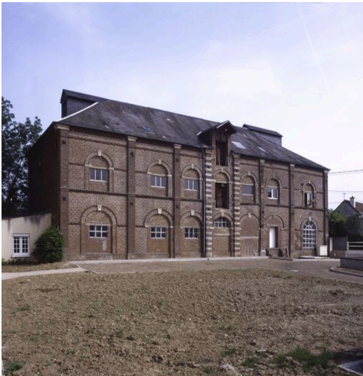
Vue d'ensemble sud-ouest de l'atelier de fabrication.
