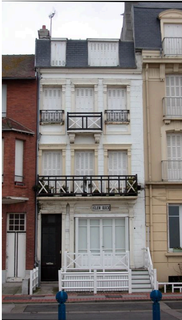
Vue d'ensemble de la maison dite Glen Rock, depuis l'esplanade.
