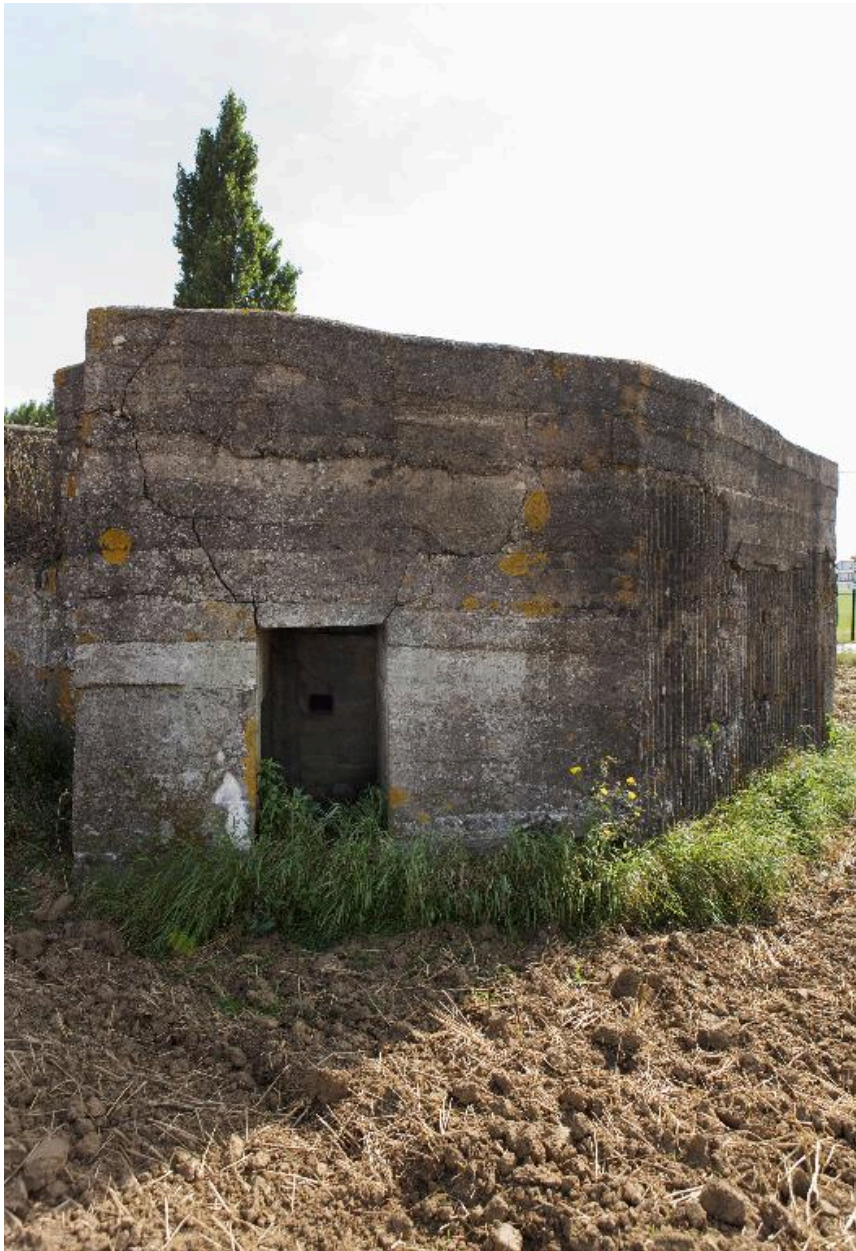
Vue latérale, entrée nord
