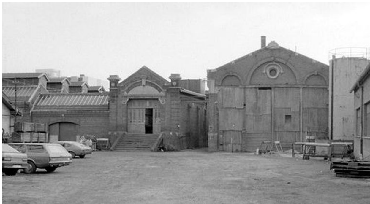
Chaufferie (à droite) et salle des machines (à gauche).
