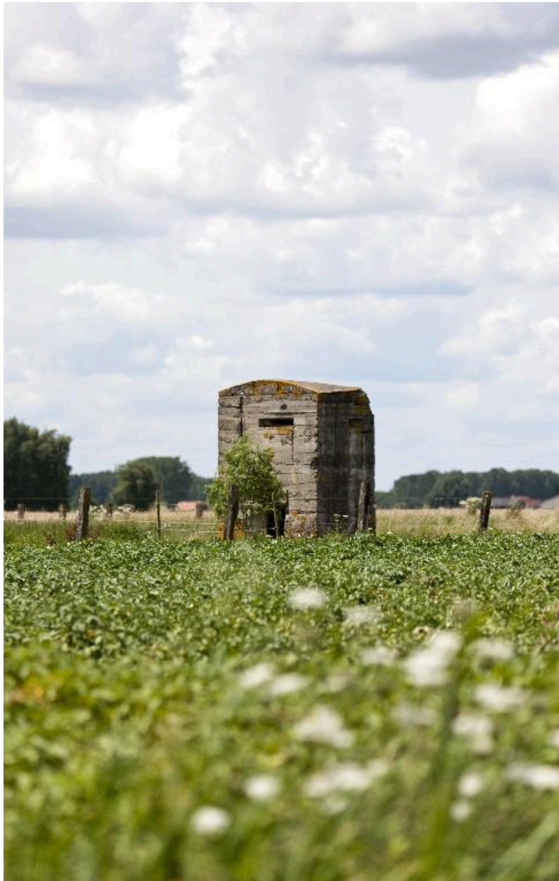
Vue générale vers le nord-ouest
