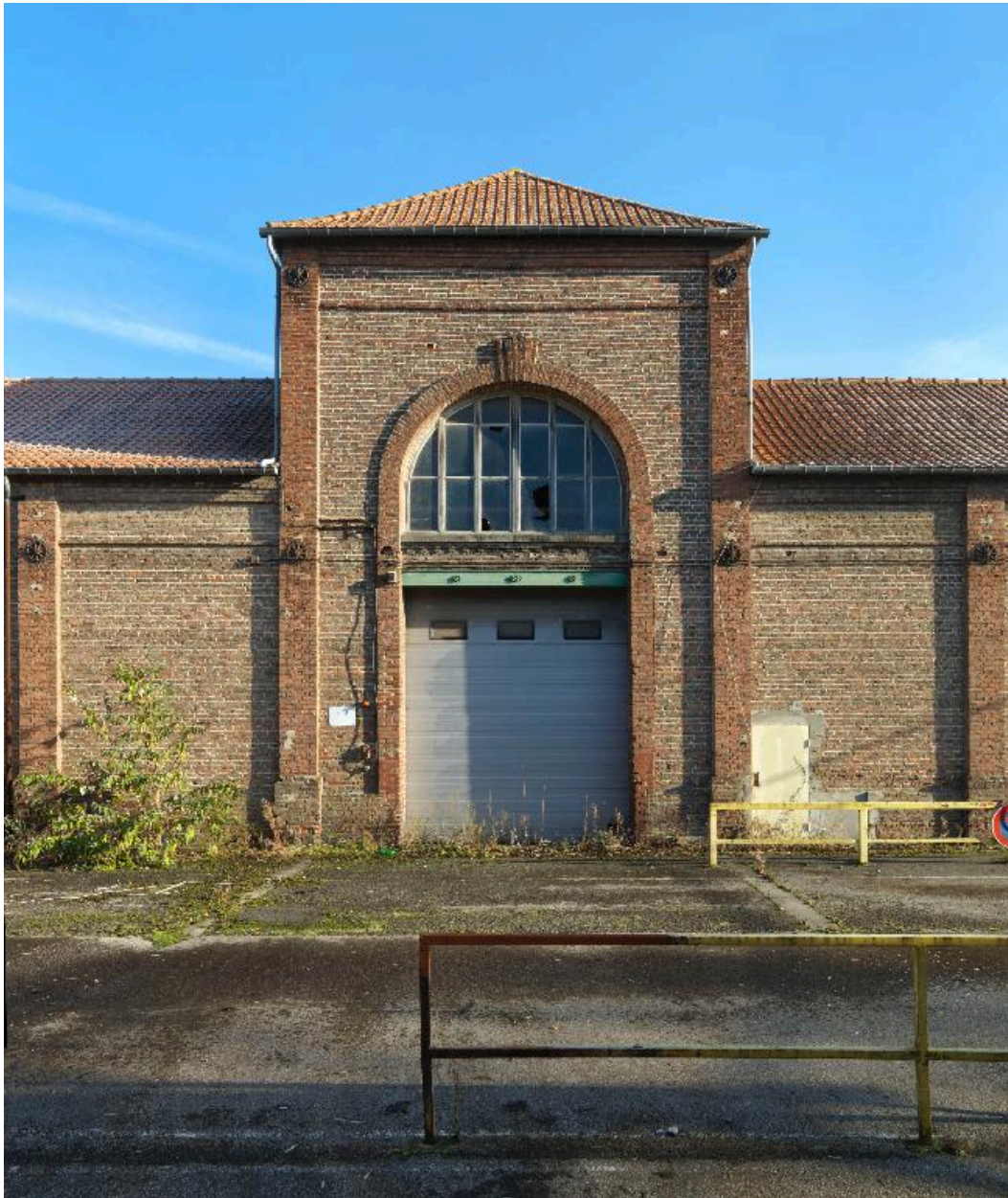
Porche d'entrée du grand entrepôt à jute.
