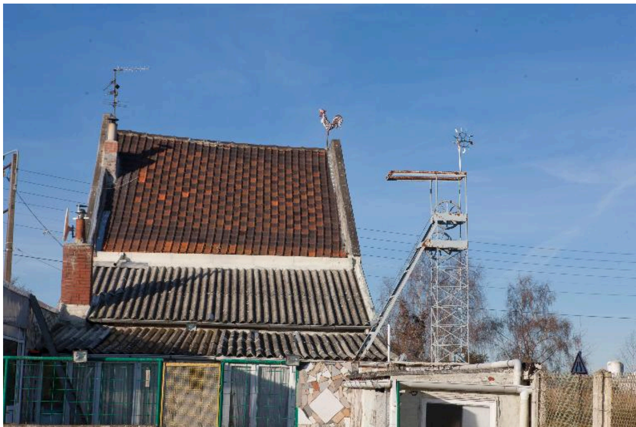
Vue partielle de l'arrière de la maison.
