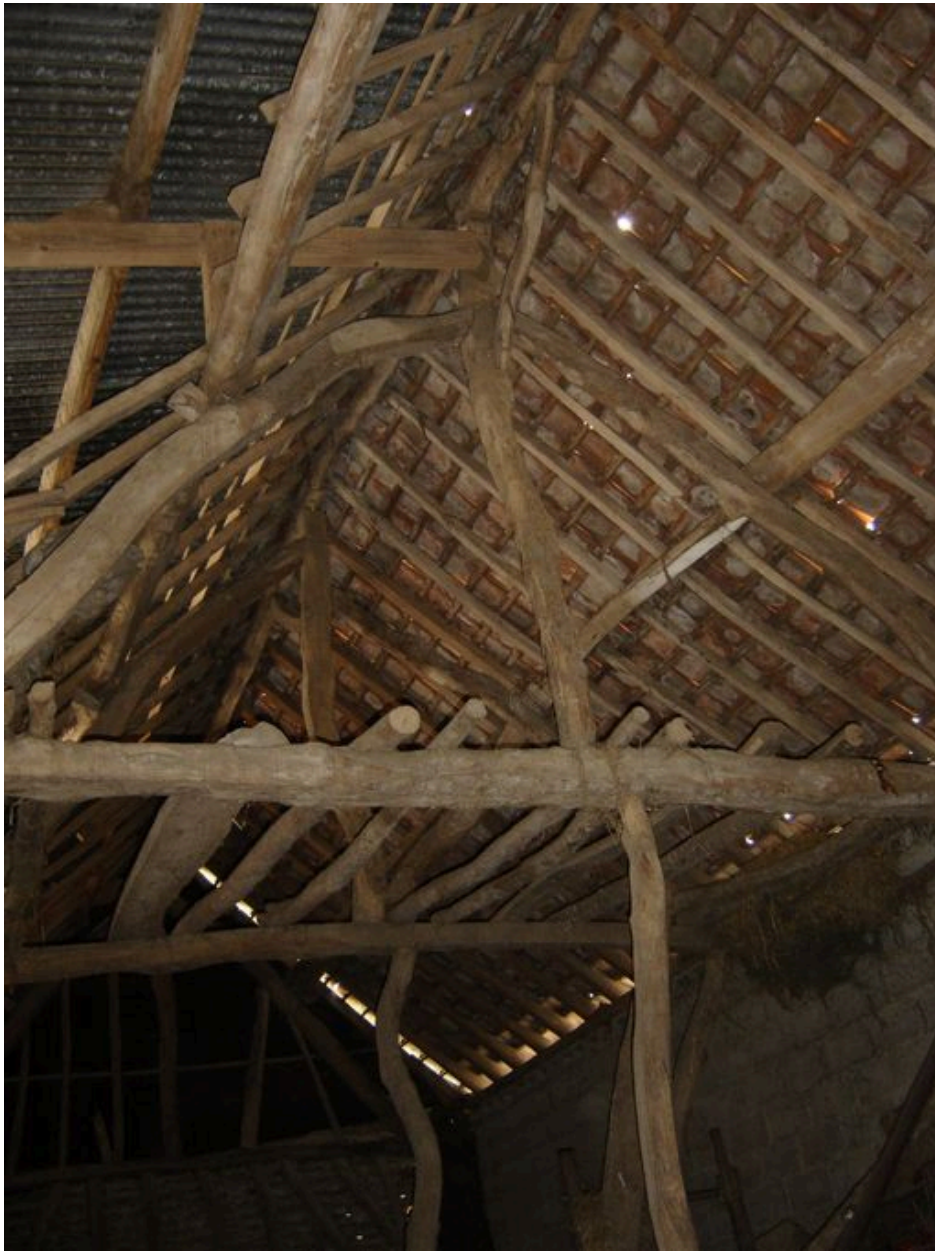
Vue de la charpente de la grange.
