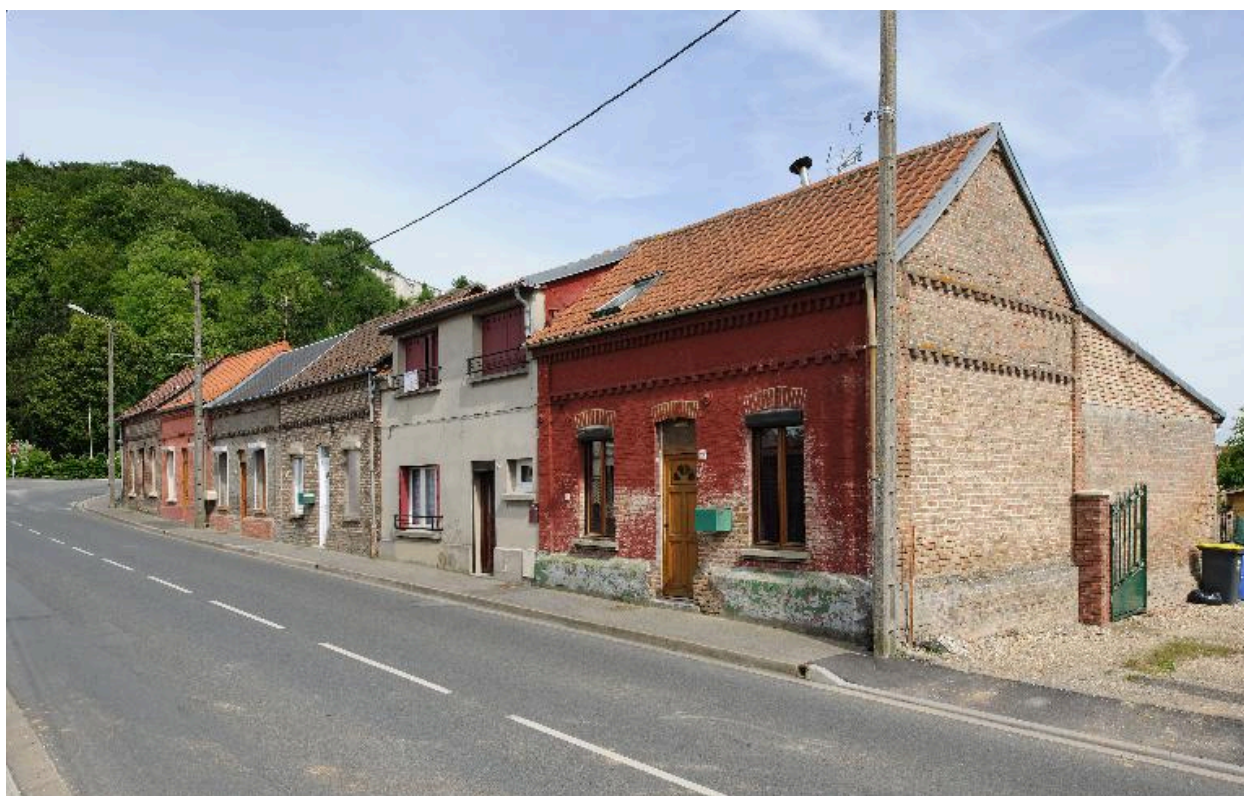
Vue d'ensemble sur rue.
