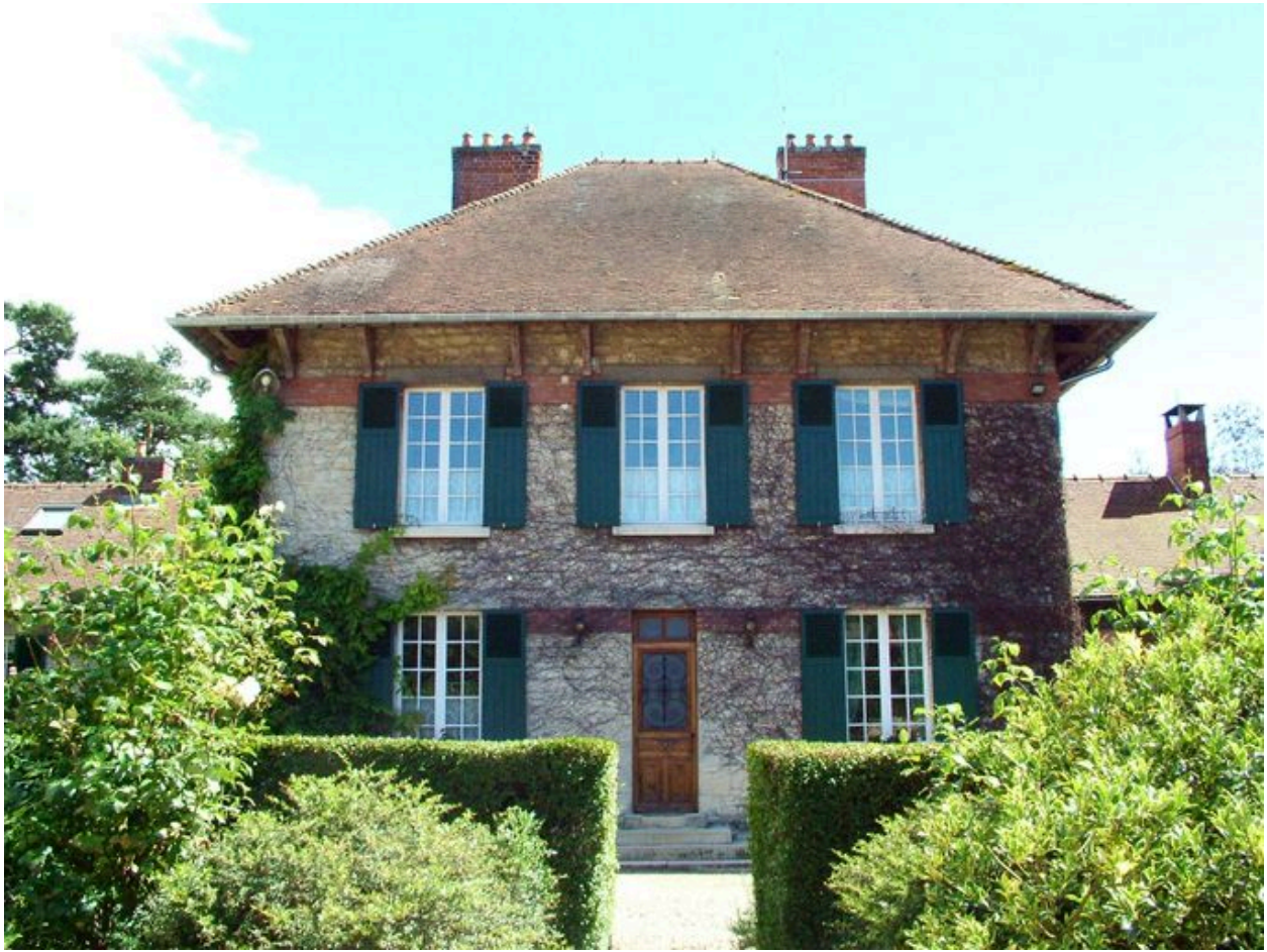
Vue du logis de la ferme du château.
