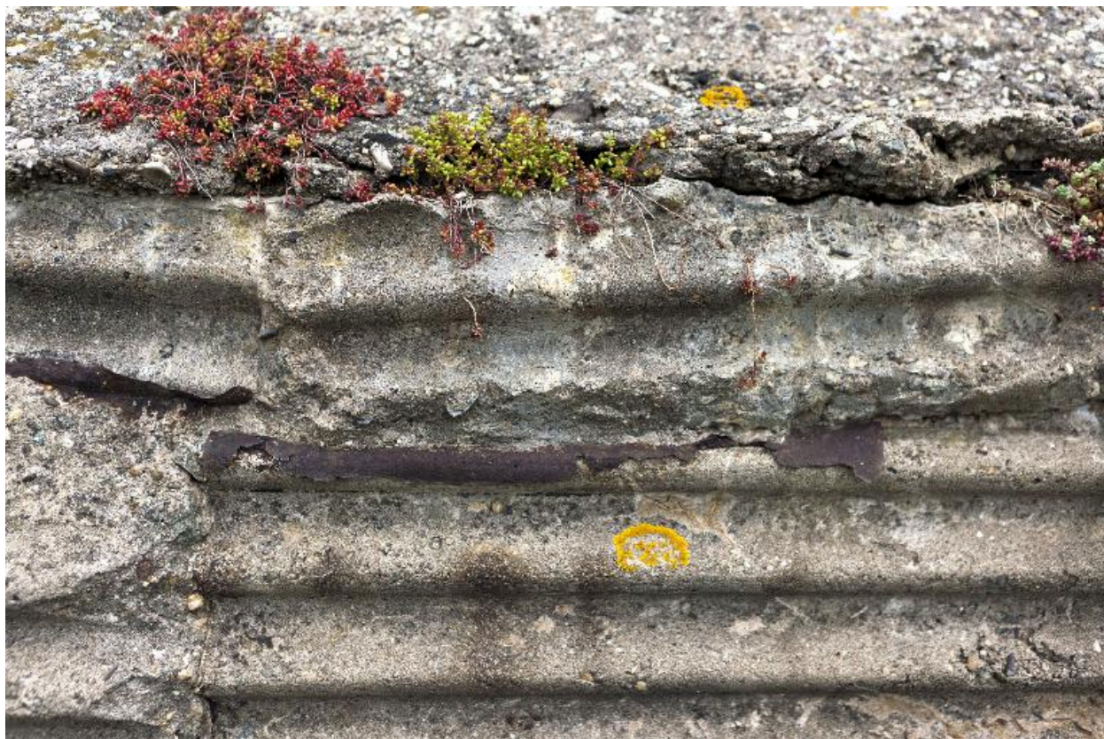
Empreinte de coffrage
