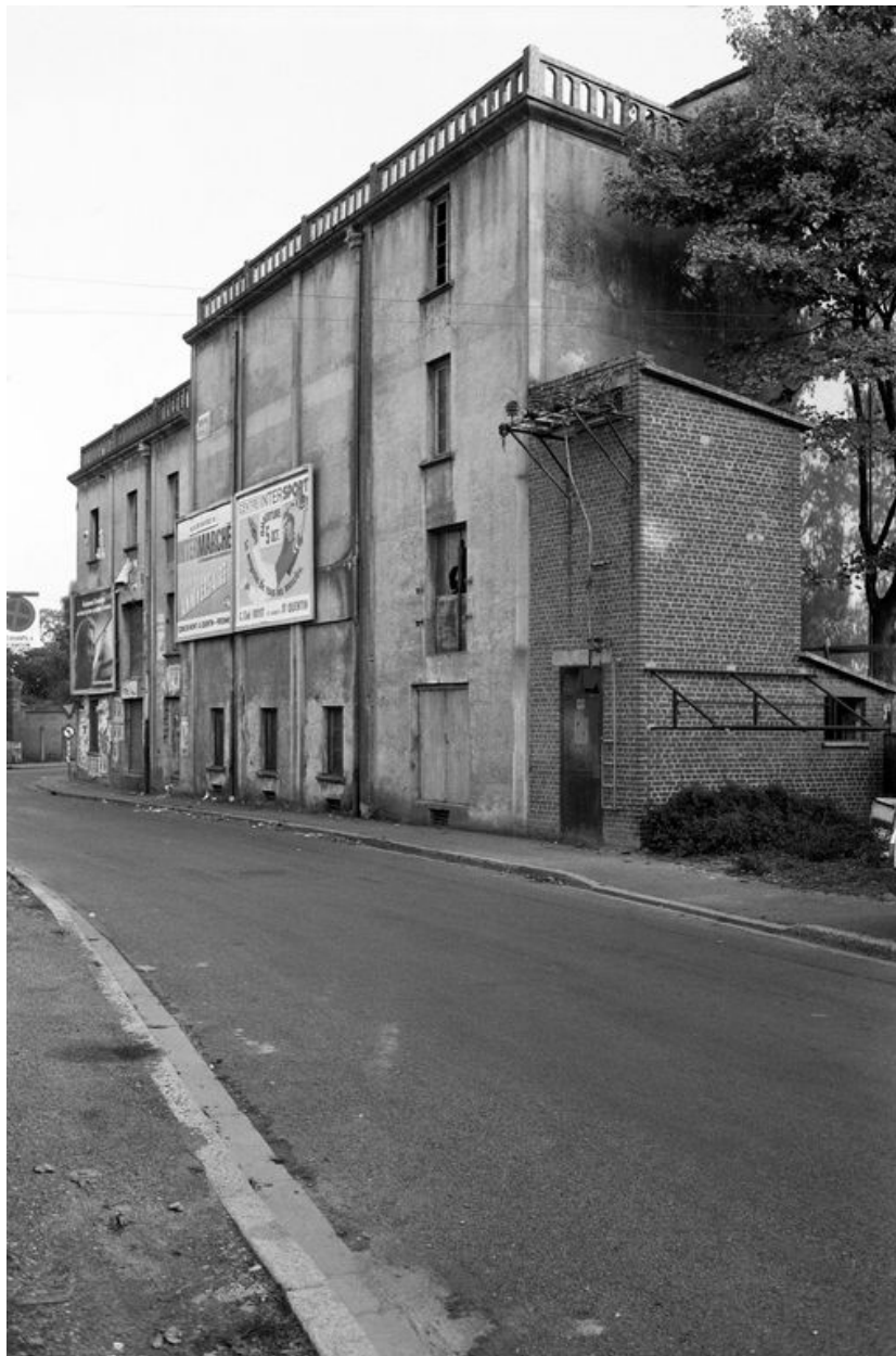
Vue partielle, flanc nord.
