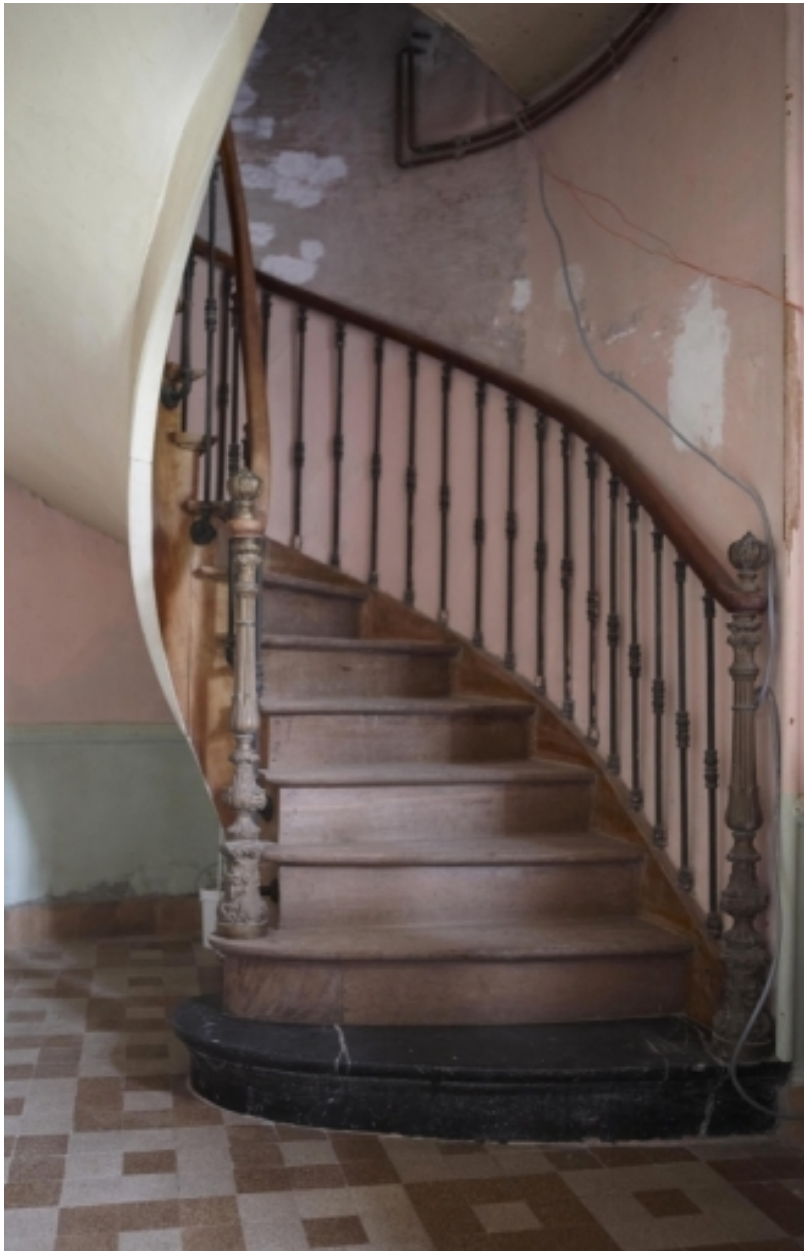
Vue de l'escalier situé dans le bâtiment abritant les pièces de réception.
