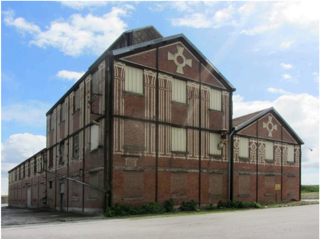
Vue d'ensemble nord-ouest de la râperie.
