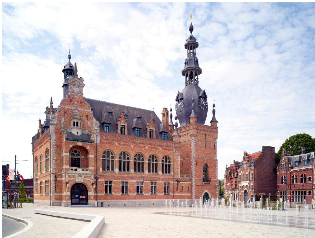
Vue générale depuis la Grand'Place, à l'est.
