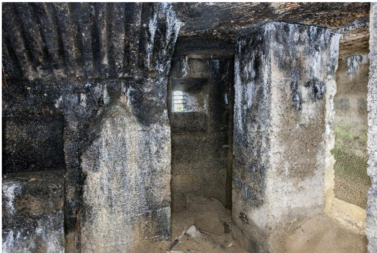
Créneau de fusillade nord vers le couloir
