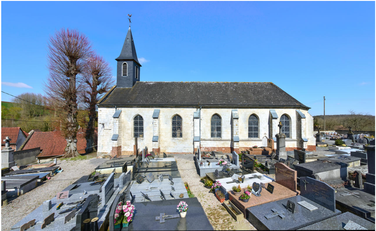
Vue de l'élévation sud.
