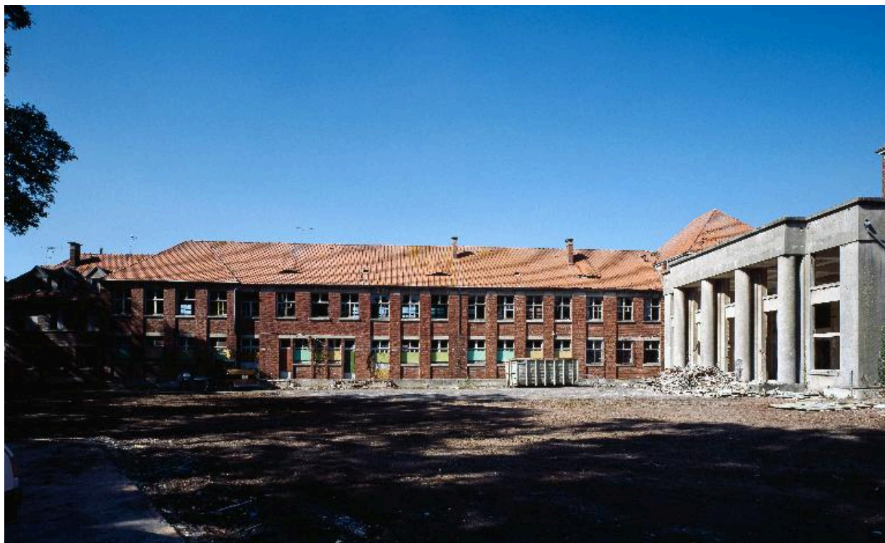
Façade postérieure, avenue Danicourt.
