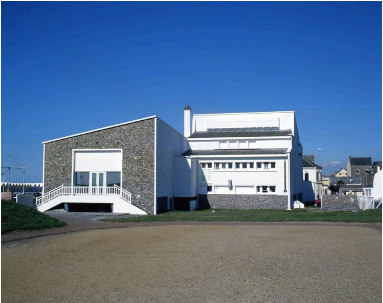
Elévation postérieure, casino actuel.
