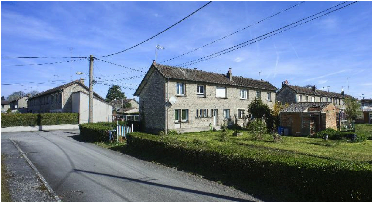
Maison à deux unités d'habitation (4-6, rue de Verdun). Vue des façades sur jardin depuis la rue du Maréchal Foch.
