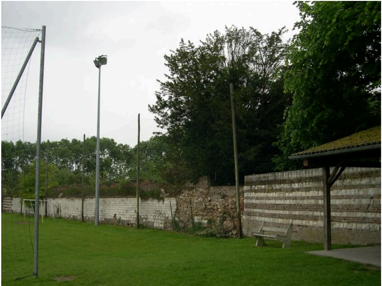
Mur de clôture, au nord de l'ancien verger de l'abbaye.
