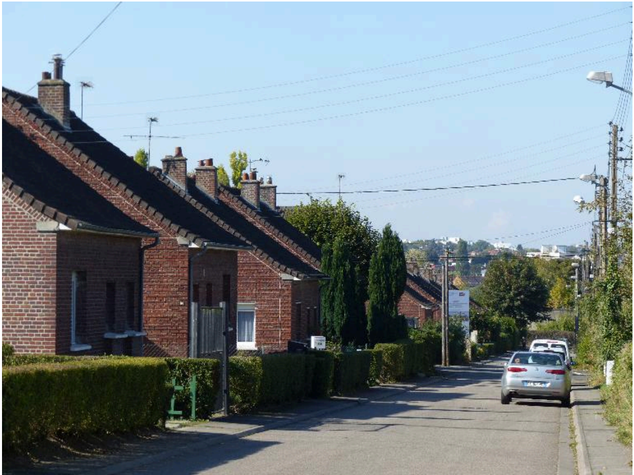
Rue Pasteur. Maisons en rez-de-chaussée construites en 1946.
