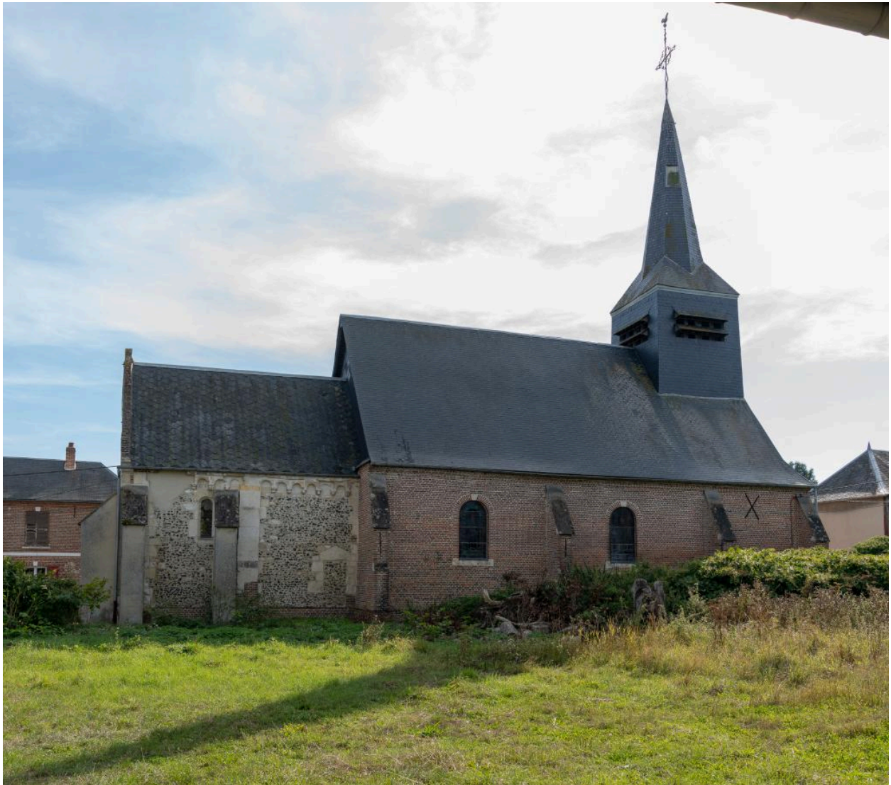
Vue depuis le nord.
