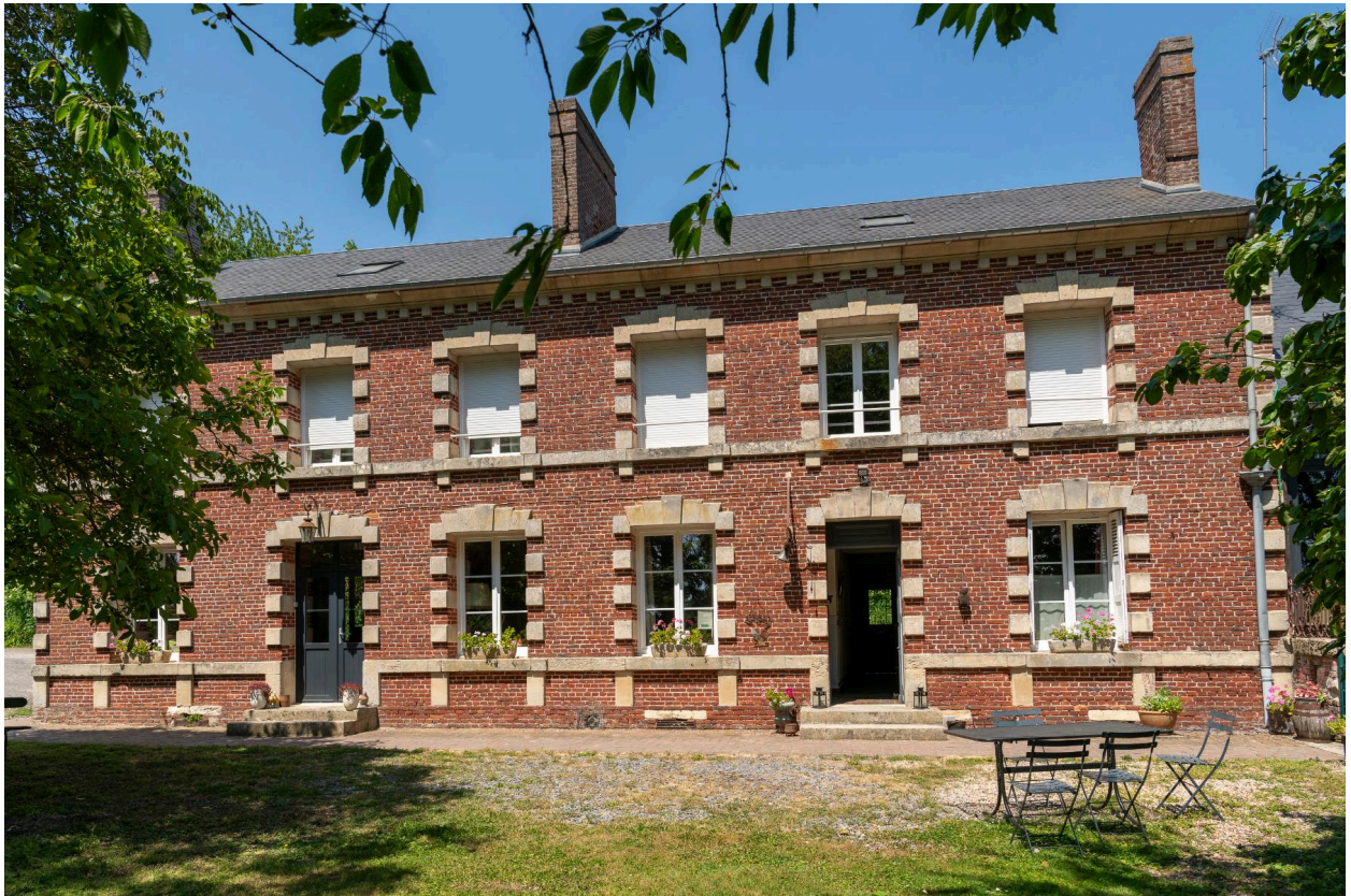
Ancien logis du fermier, aujourd'hui gîte, vue prise depuis le sud.
