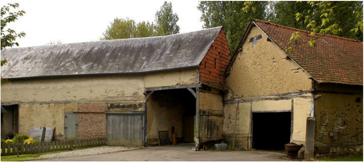
L'entrée charretière et les dépendances agricoles, façade sur cour.
