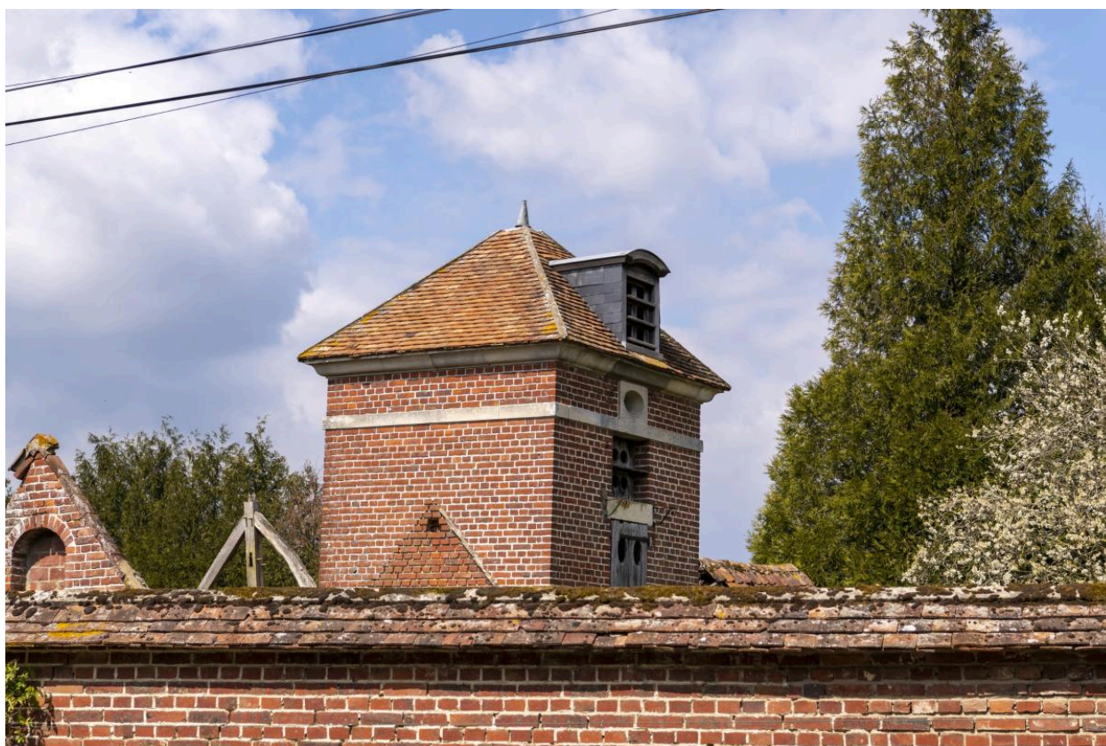
Ancien pigeonnier, n°22 rue de Bonlier, vue depuis le sud.
