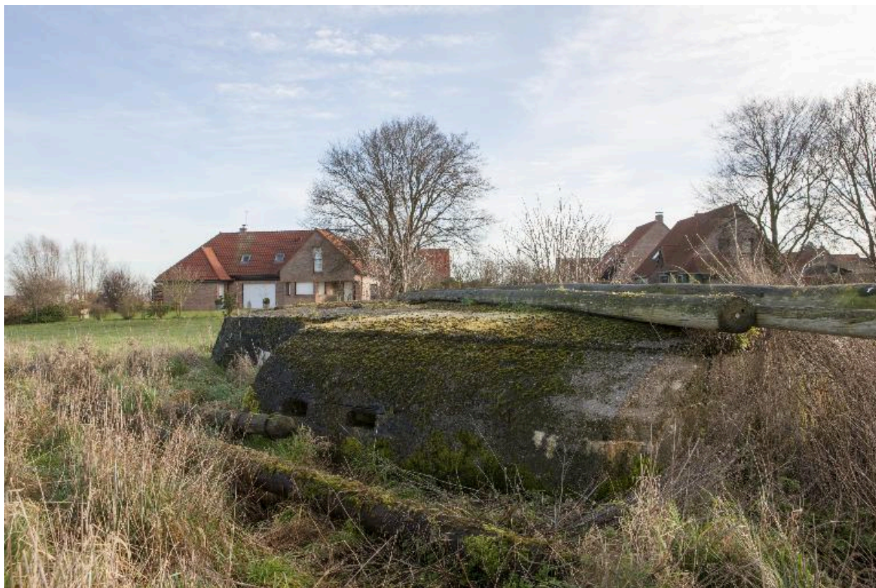
Casemate B : Vue de trois-quarts vers le nord-est
