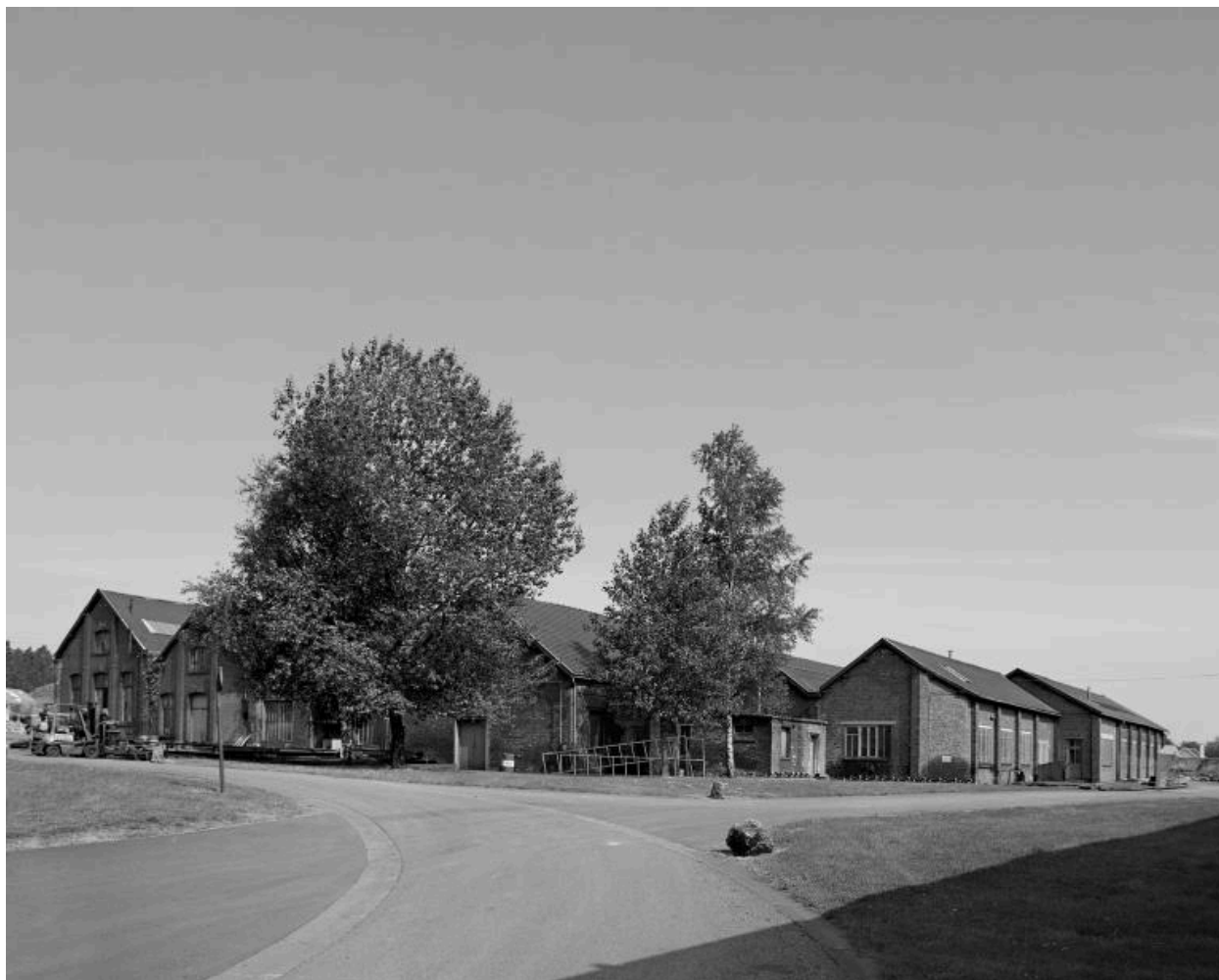
Vue extérieure des bâtiments industriels.
