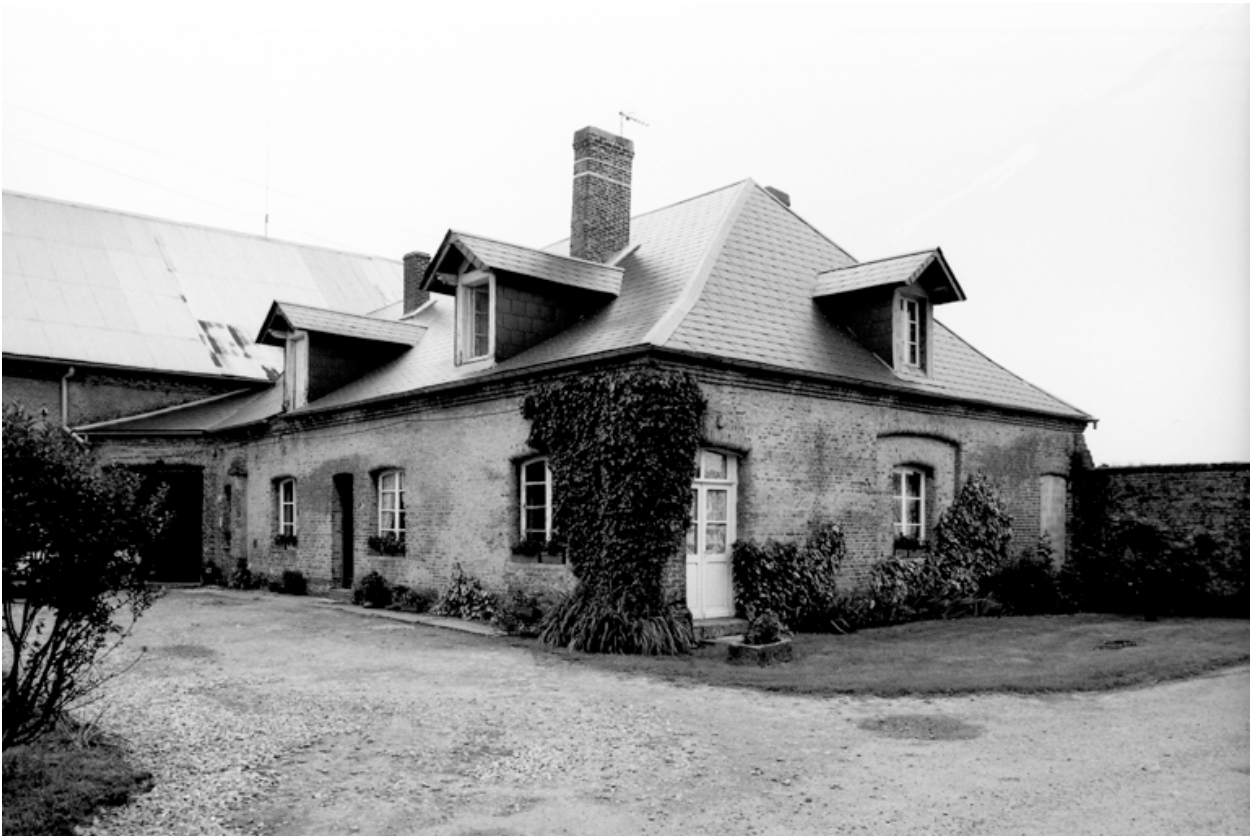
Détail du logement attenant à l'étable sud.
