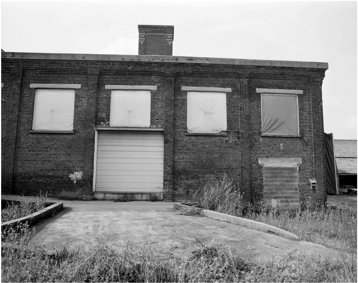
Ancienne chaufferie, rampe d'accès.
