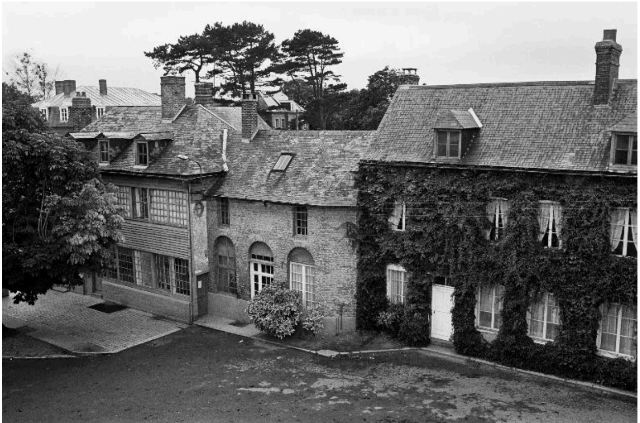
Conciergerie, bureau et vestiaires, flanc est, en 1990.
