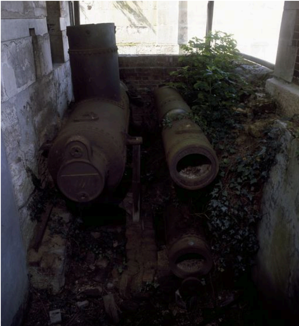
Chaudière tubulaire à deux bouilleurs.
