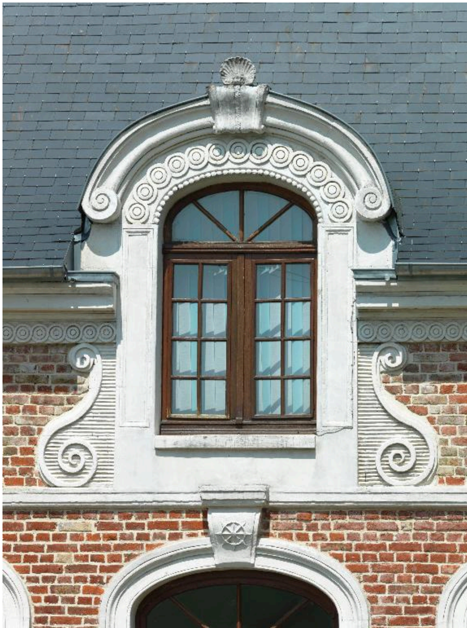
Détail de la lucarne de toit.
