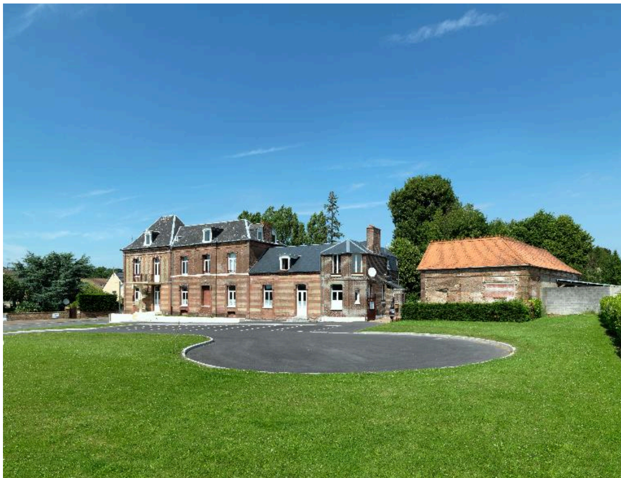
Ancien logement patronal Caqueret.
