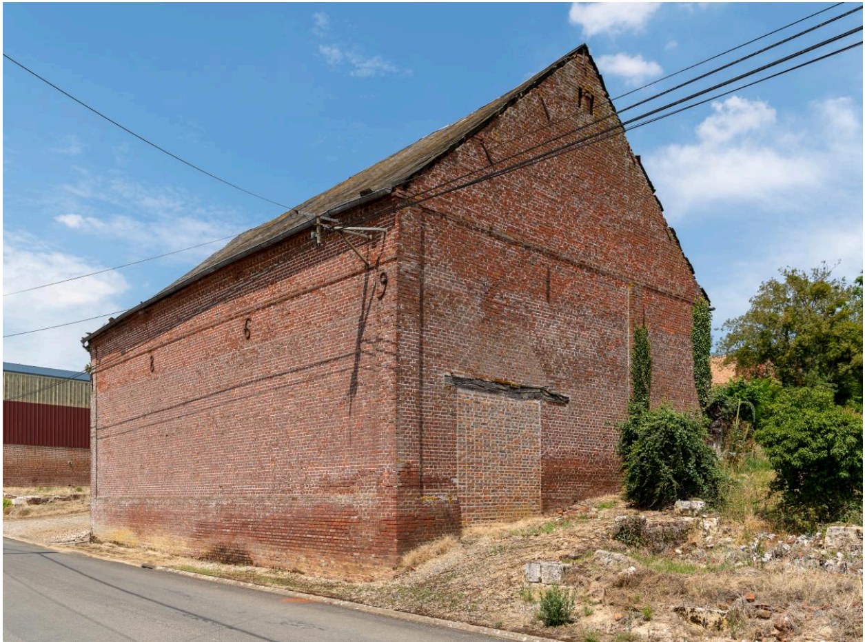
Bâtiment agricole avec date portée de 1869, n°14 rue des Bonhommes, vue depuis le sud.
