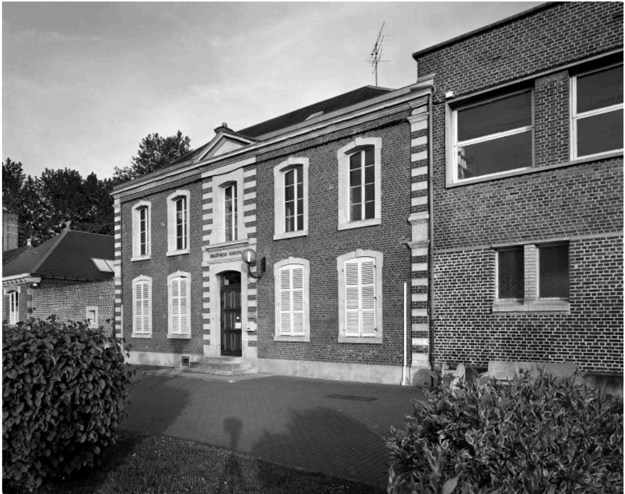
Vue du pavillon latéral construit pour l'école des filles, abritant aujourd'hui la bibliothèque municipale.
