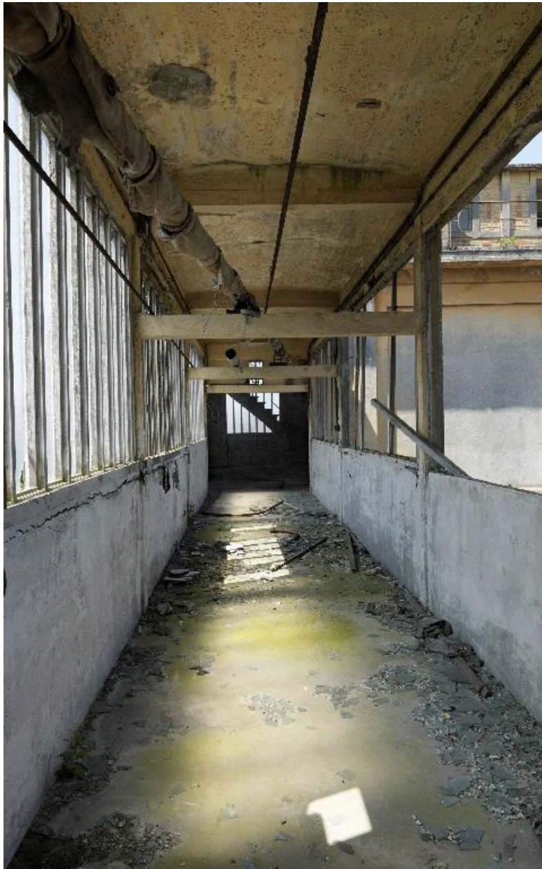
La passerelle couverte, vue intérieure.
