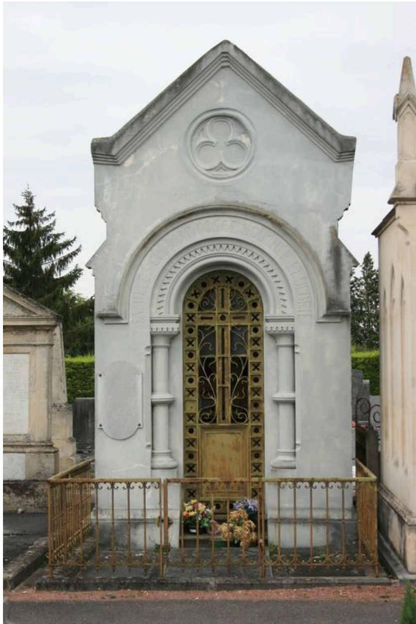
Vue de la façade antérieure.
