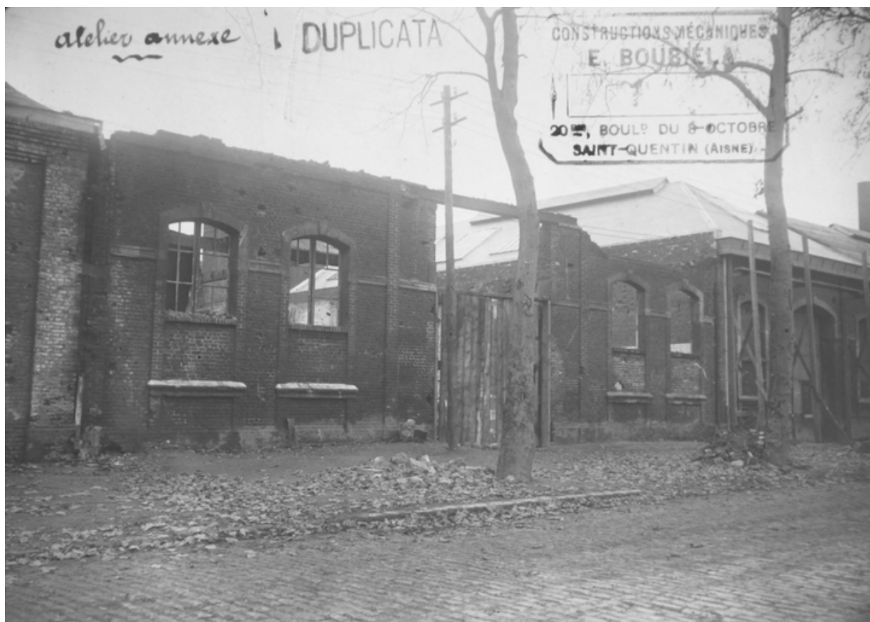
Façade de l'atelier annexe, boulevard Léon Blum. A droite, l'atelier de mécanique. 1919 (AD Aisne).
