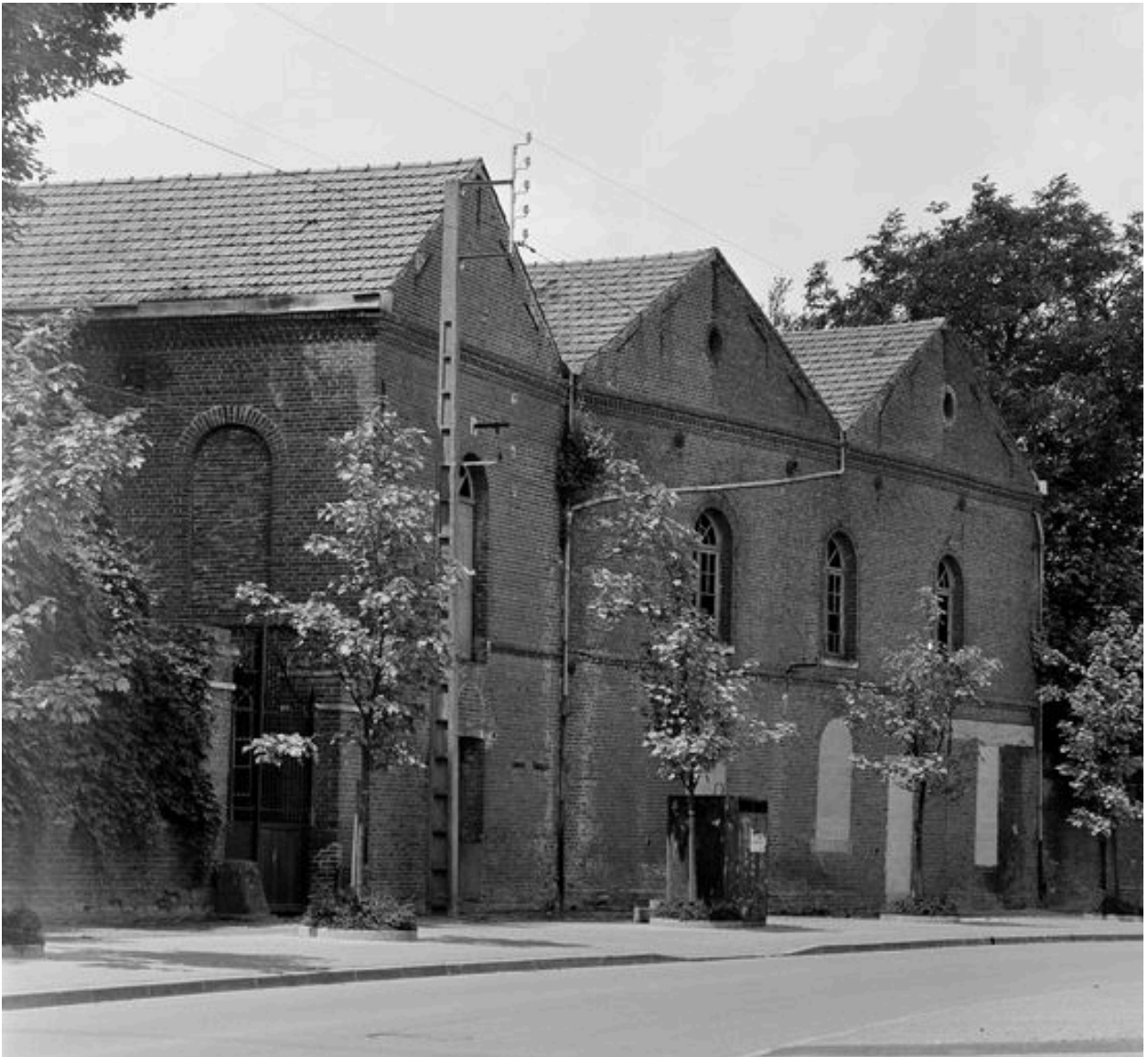
Atelier de fabrication : façade antérieure.
