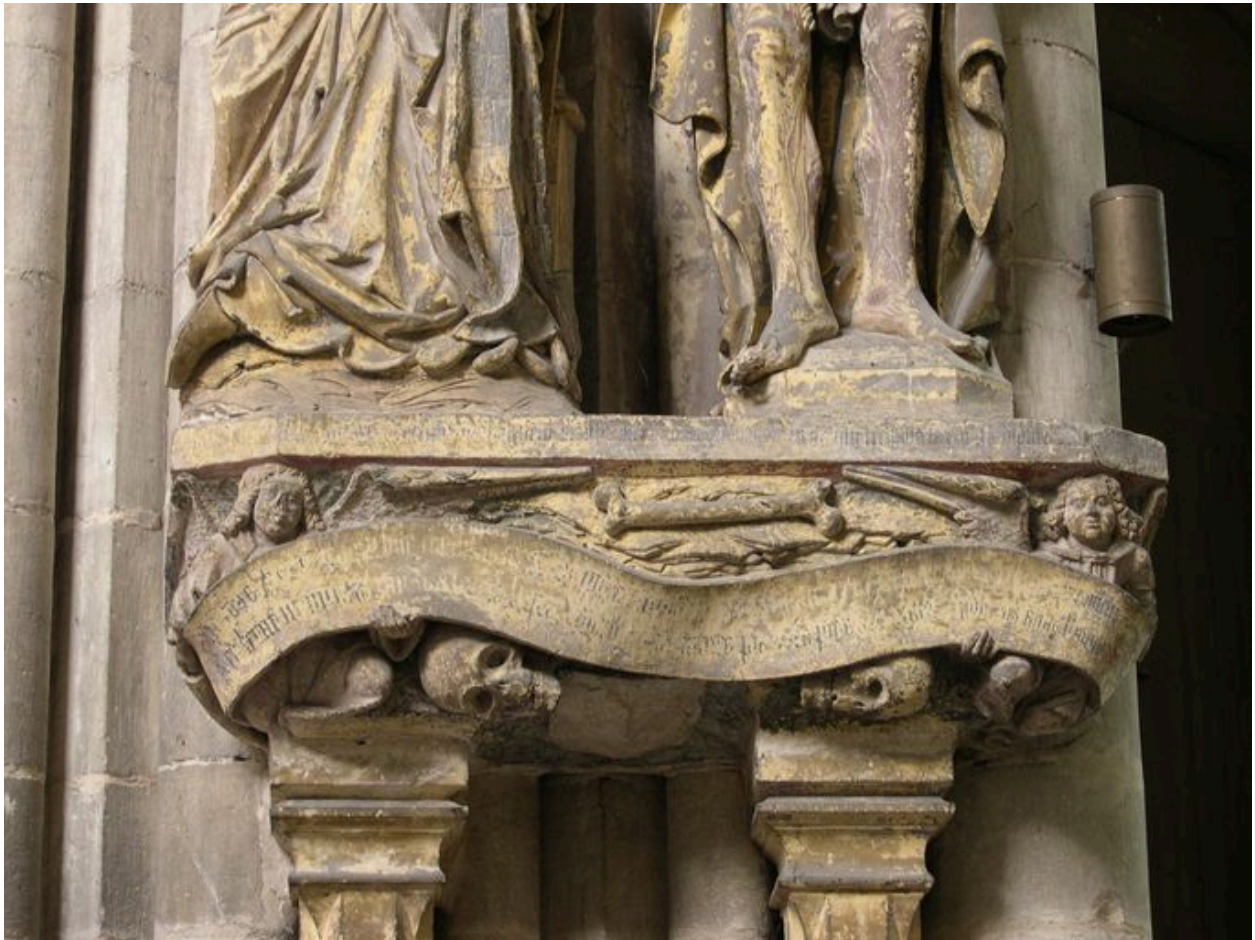
Vue de détail sur la base.
